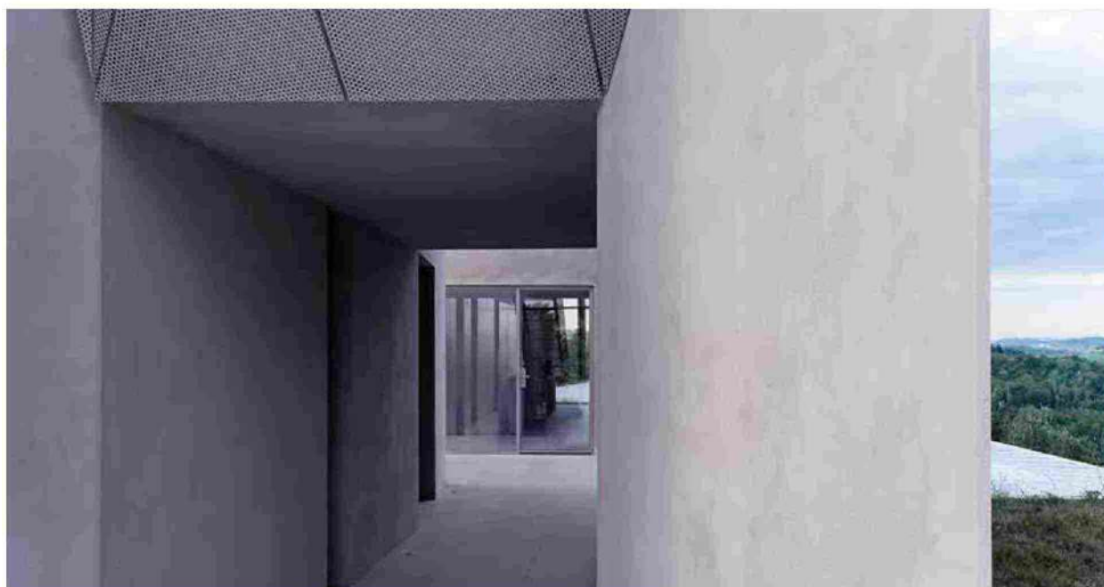
Sopra. Il corridoio che collega i due volumi.
