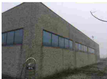
2. Il vecchio capannone abbandonato.
