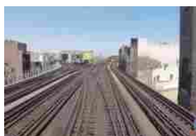
Ponti, binari e strutture di supporto per la linea ferroviaria di Chicago
