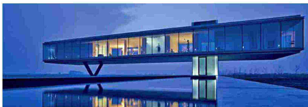
Villa Kogelhof - architetto Paul de Ruiter, committente Ton Zwijnenburg - Premio Internazionale Dedalo Minosse edizione 2013/2014.
