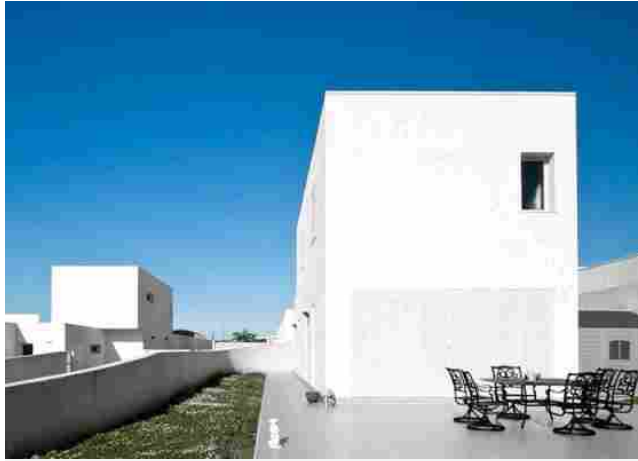
Il complesso A2M social Housing, Ragusa
