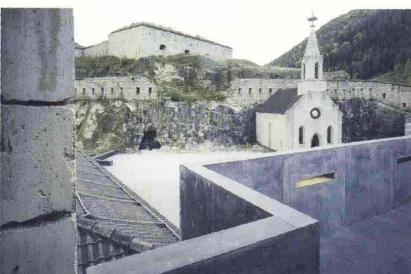
Premio Speciale GranitiFiandre Client: Provincia Autonoma di Bolzano Project: Markus Scherer con Walter Dietl Title: Recupero del Forte di Fortezza Construction: 2009, Fortezza (Bolzano), Italia
