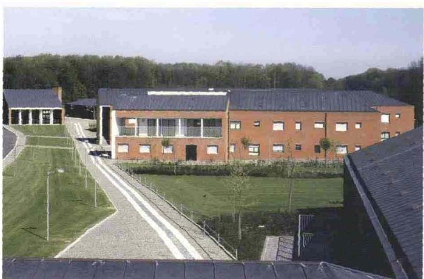
Premio Speciale Design for All Italia Client: Lega del Filo d'Oro Onlus Project: Guidarini & Salvadeo architetti associati con ingegneri Canalini e Passalacqua Project Plants: Termostudi, ing. Bruno Roccheggiani Project Structures: Marco Corti Title: Centro socio-sanitario residenziale per sordociechi e pluriminorati psicosensoriali Construction: 2006 - Lesmo (Monza-Brianza), Italia
